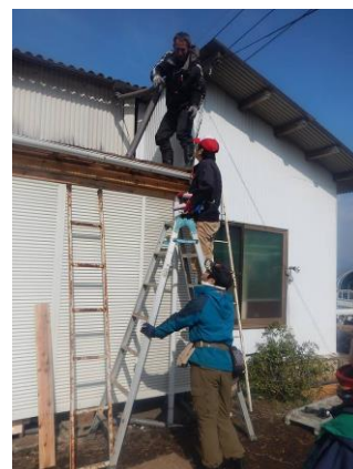
屋根の雨漏りを修繕中
