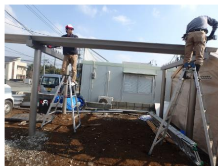
既存の車庫の解体作業
