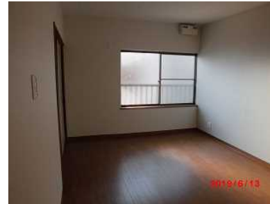
○改修後 2階洋室（201号室）
