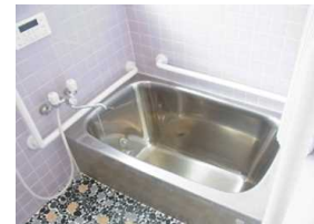
○バリアフリー改修 浴室手摺取付
