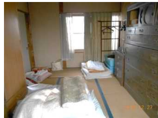
○改修前 2階和室6帖
