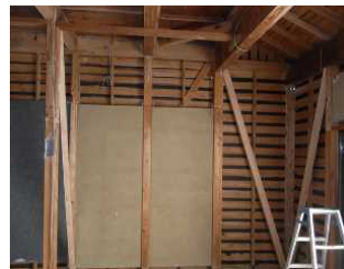
○筋交い設置(耐力壁)
