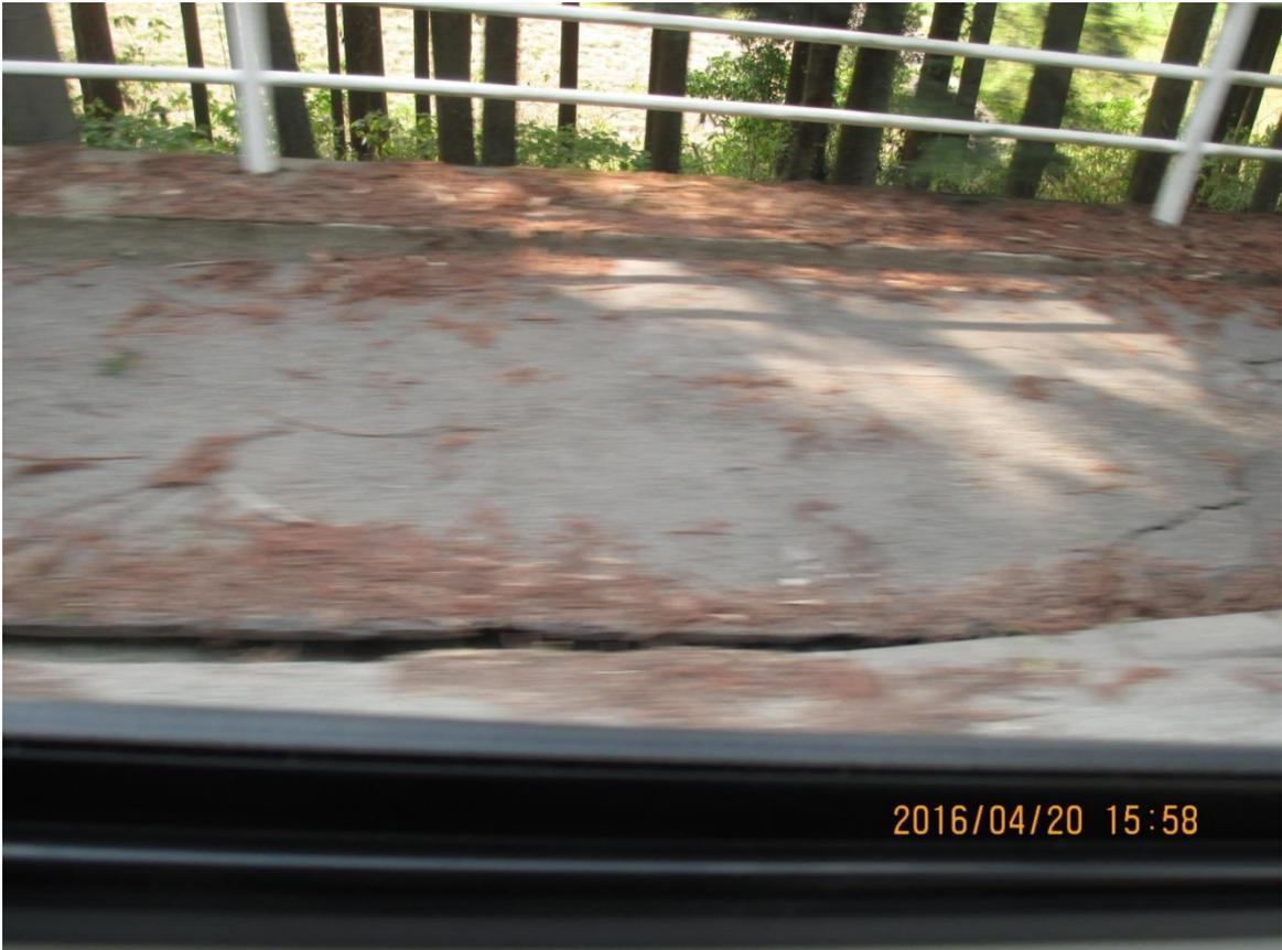
歩道と車道に亀裂が入り段差が生じる。
